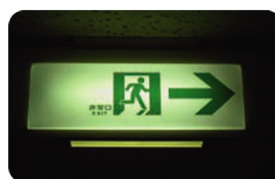
正常な表示板
